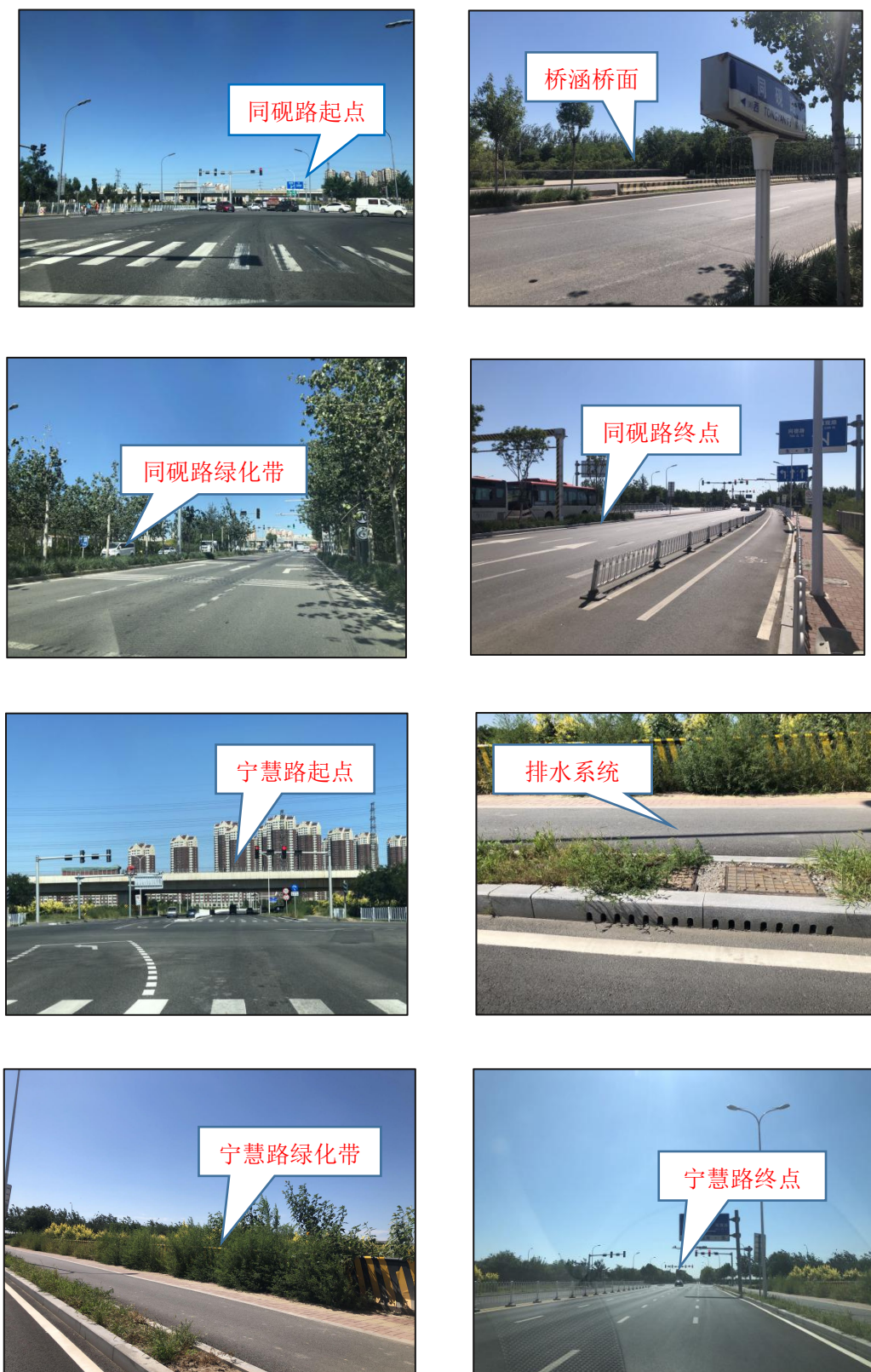
图 2.3-1 工程沿线情况照片
