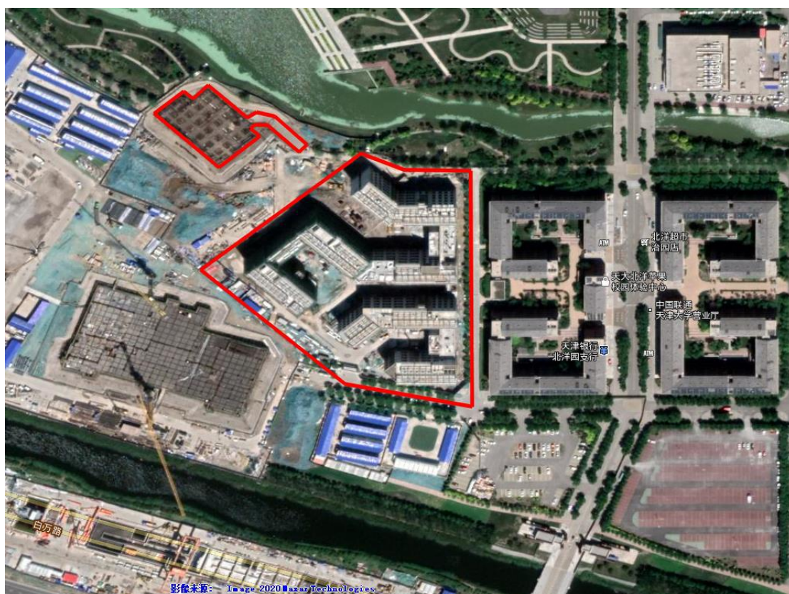
项目完建设后（2020年6月）
