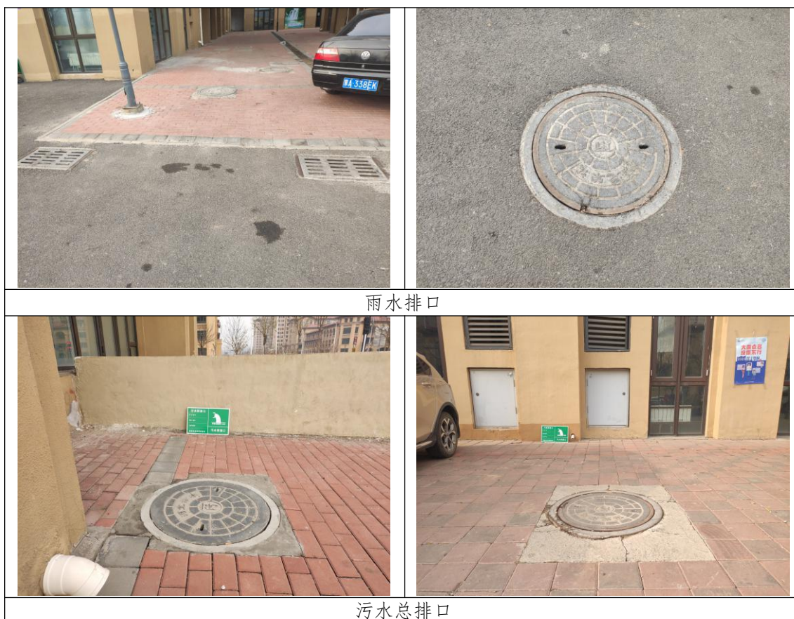
图 4.1.2.1 本项目废水总排口
