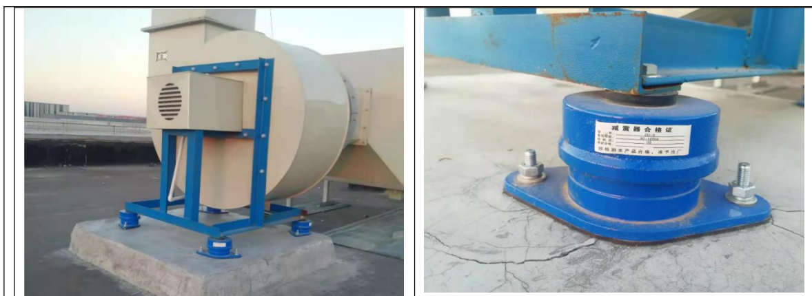
图5 本项目风机减振情况
