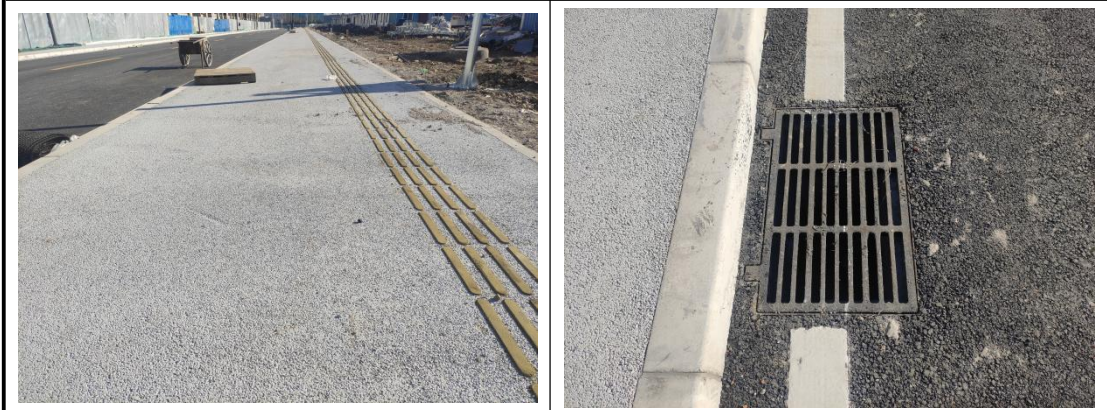
透水路面铺设
