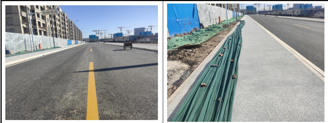
透水路面铺设
