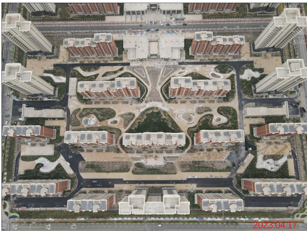
项目建设前影像图
