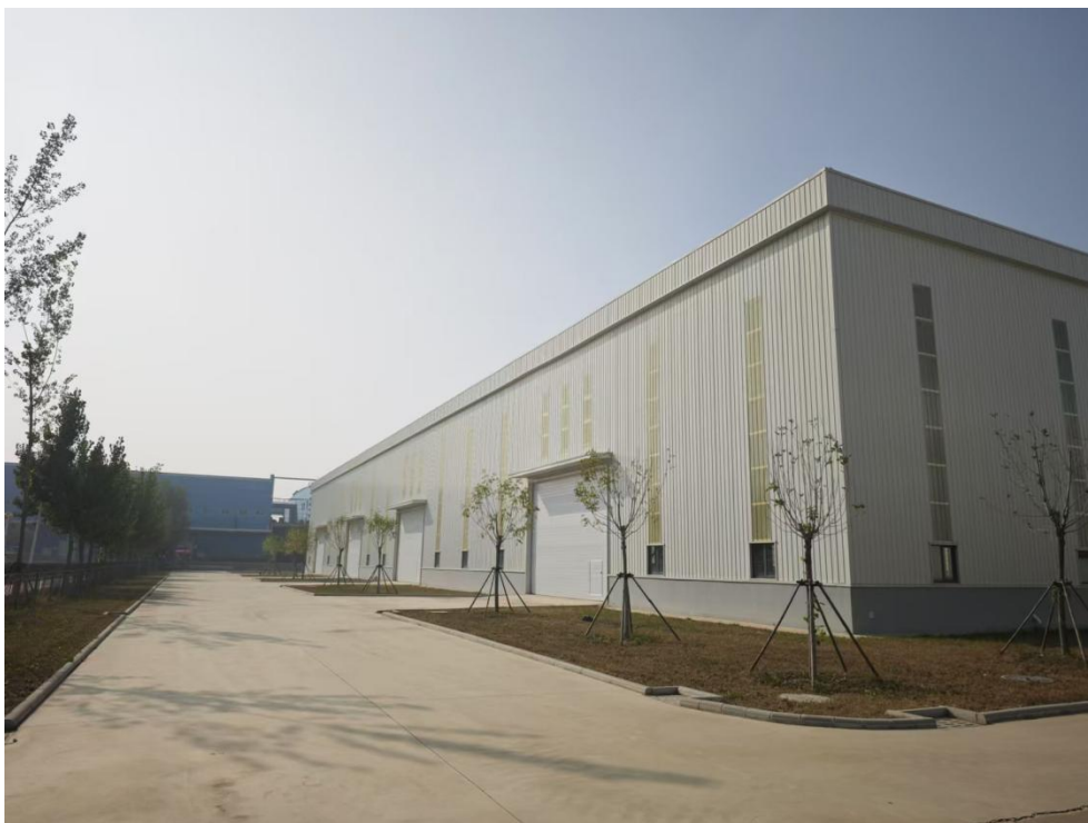
图 1.1-1 项目现场情况图
